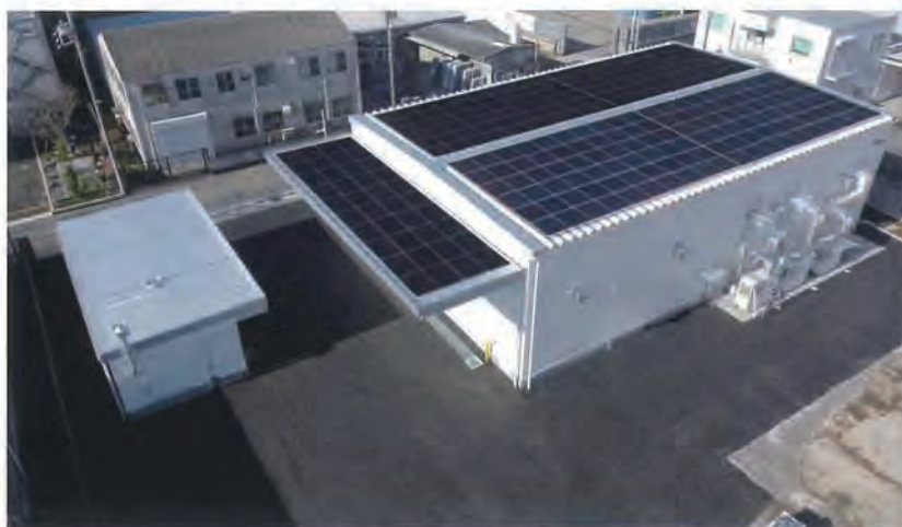
完成したばかりのインク工場。屋根にはソーラーパネルが敷き詰められている
